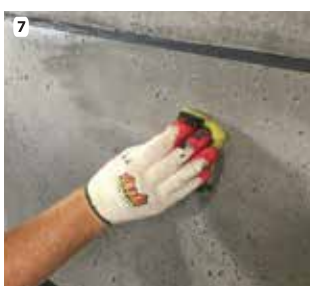
7 Удалить излишки клея при помощи мокрой губки.
