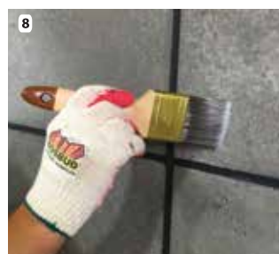
8 После высыхания клея Termolep-D, защитить бетон покрытием лака.
