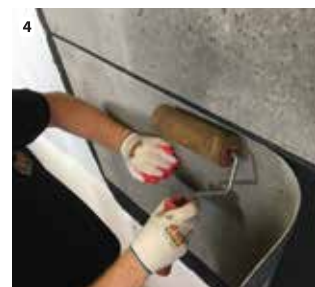
4 Приклеивая панель одновременно прижимать его с помощью валика.
