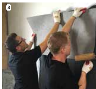
3 Приклеить панель STONO используя лазерный уровень.
