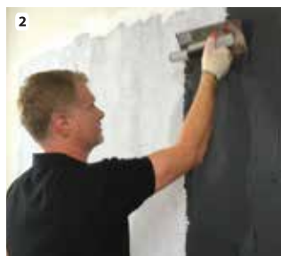
2 С помощью зубчатого шпателя 5 мм нанести дисперсионный клей Termolep-D.
